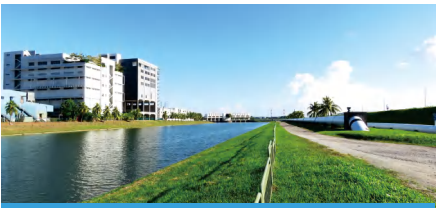
河道水位流量监测
