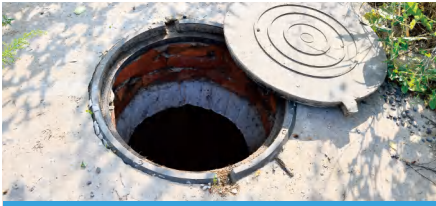
排水管网水位监测
